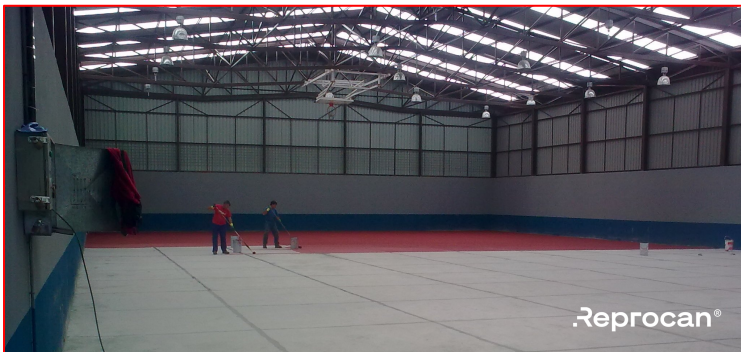
Antes (pavimento de hormigón fratasado)
